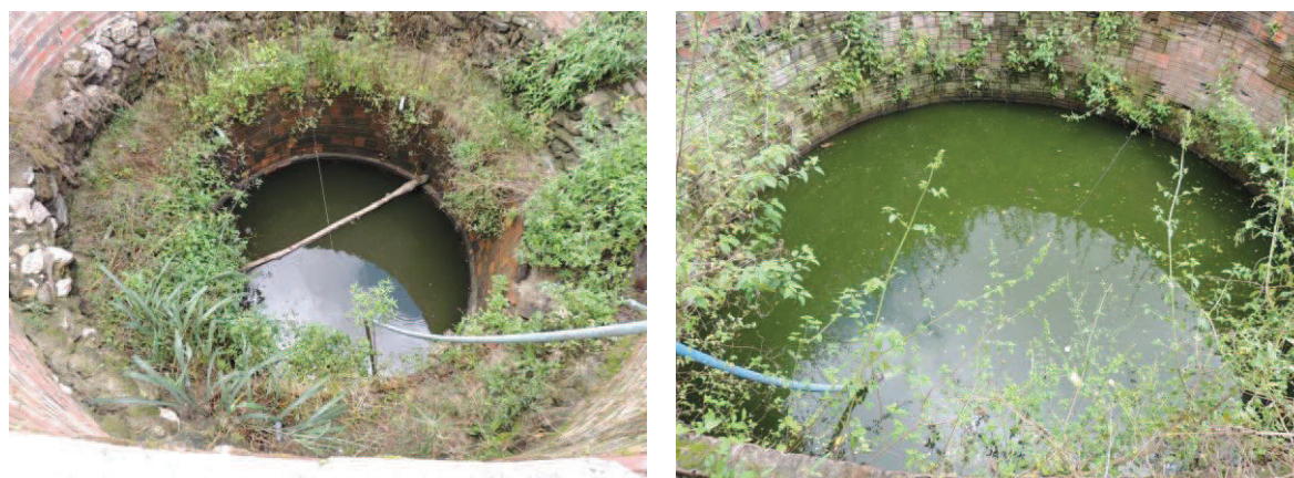
Foto 2. Poços tipo “amazonas” no assentamento Santa Rita
