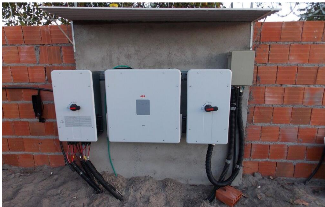
Figura 50 - Inversor instalado.
