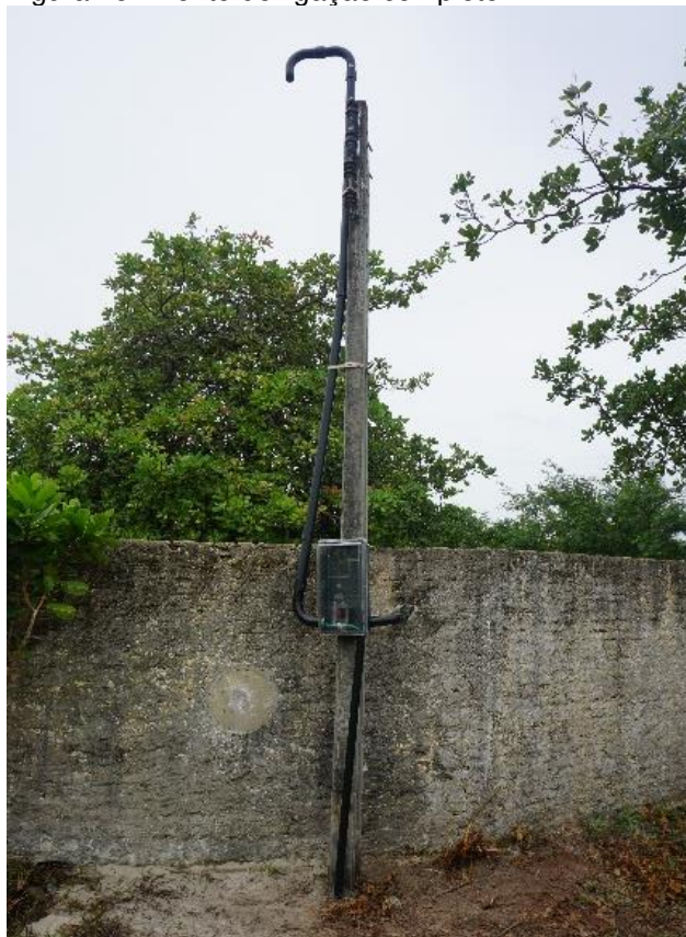
Figura 25 - Ponto de ligação completo.
