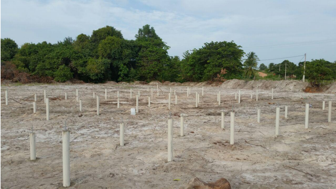
Figura 30 - Fim da instalação das bases de concreto
