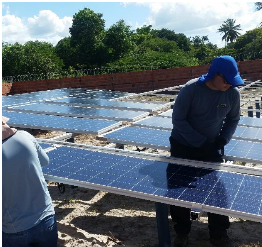
Figura 45 - Instalação de painéis FV.
