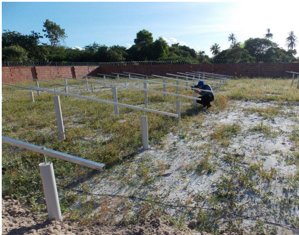
Figura 38 - Colocação de barras metálicas.
