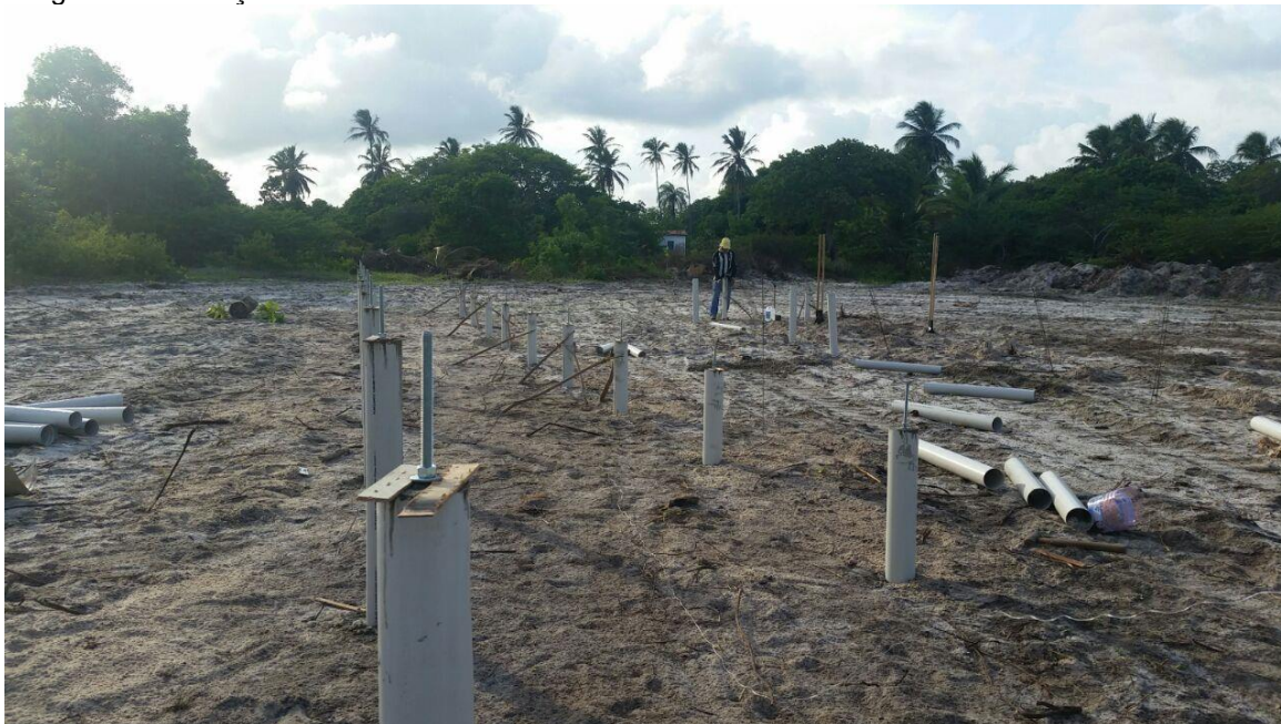
Figura 28 - Fixação das estruturas em PVC
