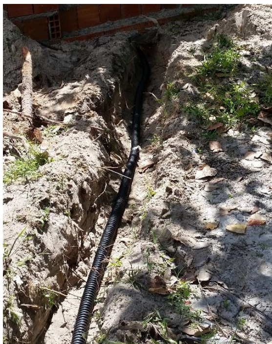
Figura 36 - Eletroduto CA em vala.
