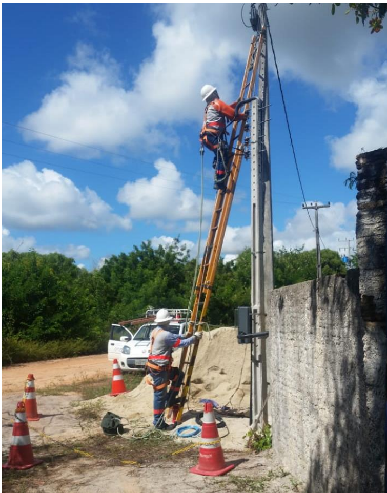
Figura 42 - Conexão do ponto de ligação à rede aérea.
