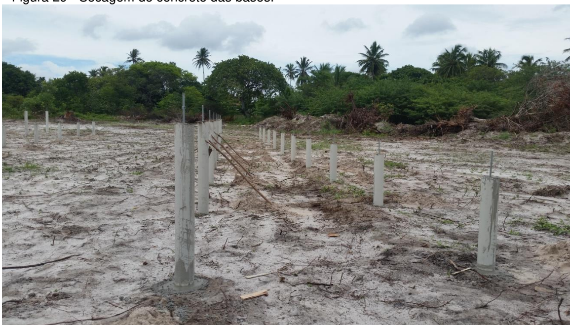
Figura 29 - Secagem do concreto das bases.
