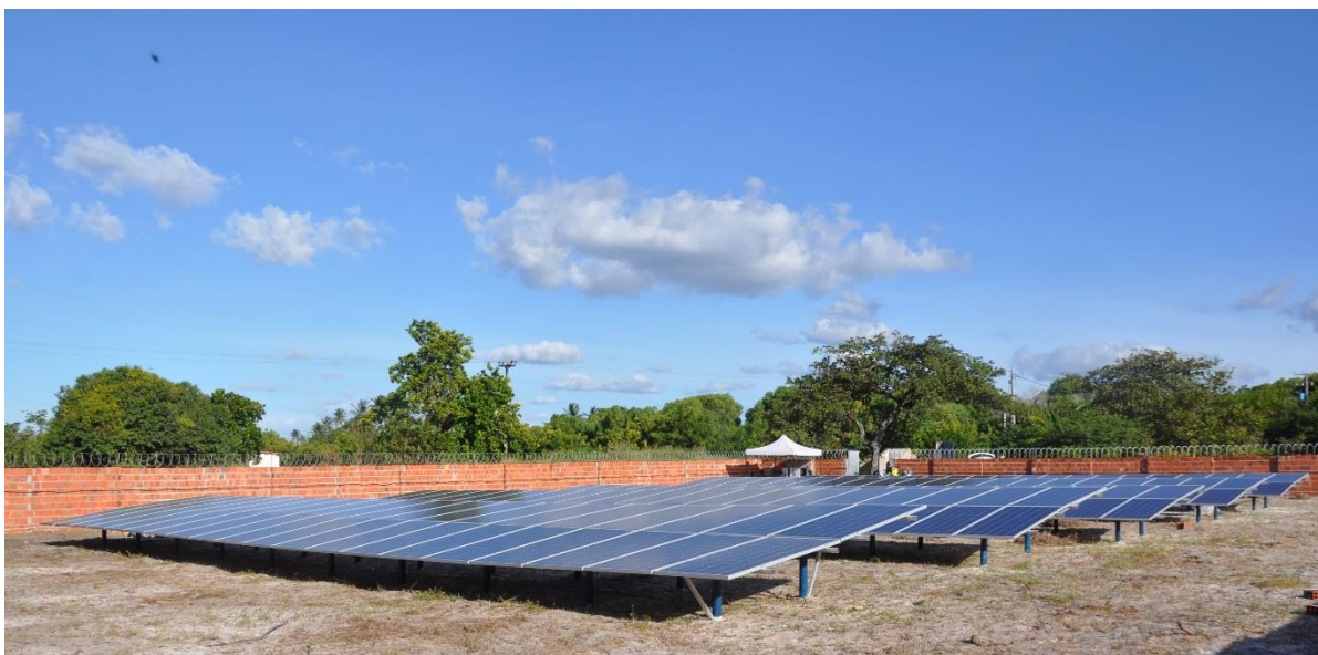
Figura 48 - Conclusão da instalação de painéis FV.
