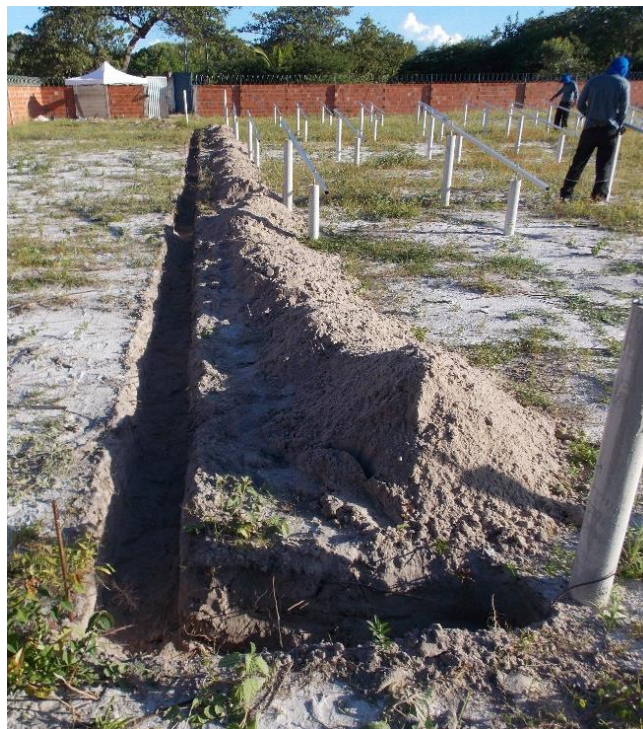
Figura 35 - Valas da malha de aterramento.
