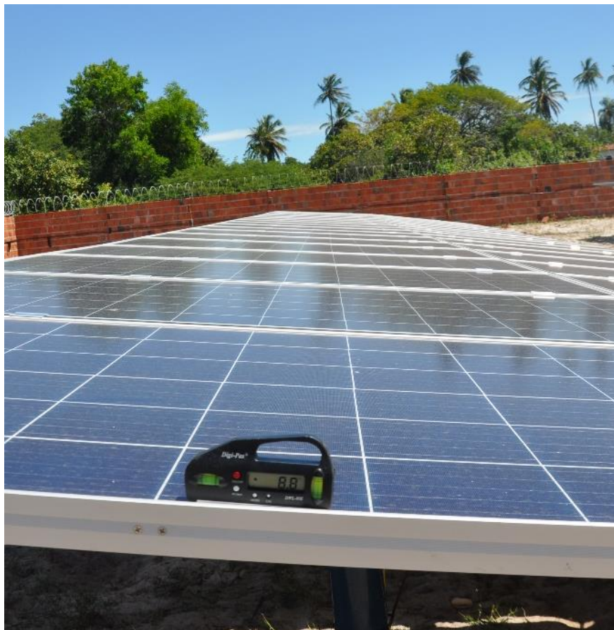
Figura 46 - Inclinação dos painéis FV.
