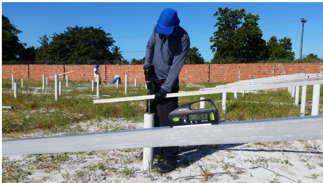
Figura 39 - Alinhamento de barras metálicas.
