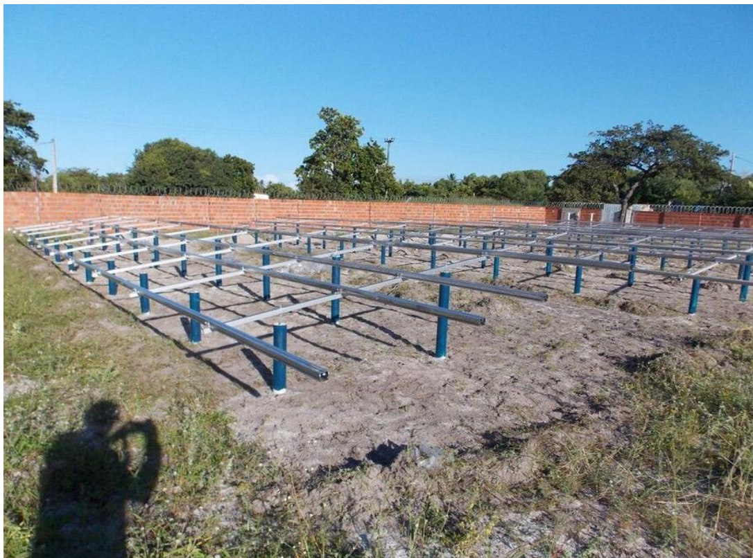
Figura 41 - Estruturas de fixação concluídas.
