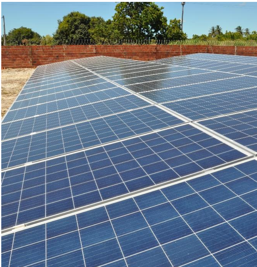
Figura 47 - Estrutura de painéis completa.
