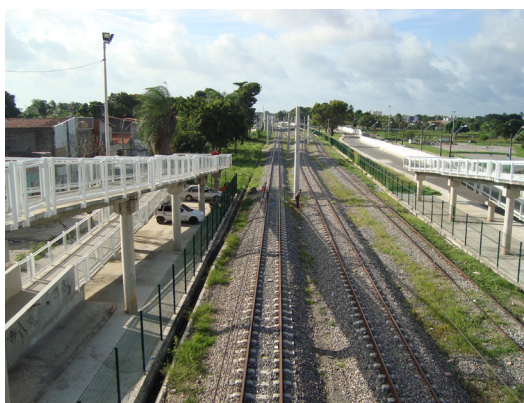
FIGURA 16 Vista superior a partir de uma das passarelas para a linha férrea cercada por grade dos dois lados FONTE: Autora
