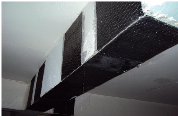
Figura 10 – Fibra de carbono aplicada como reforço em viga
