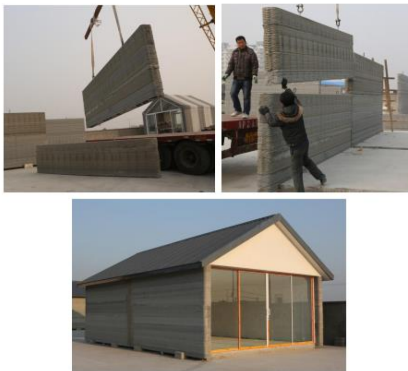
Figura 16 – Montagem de casa impressa em 3D.
