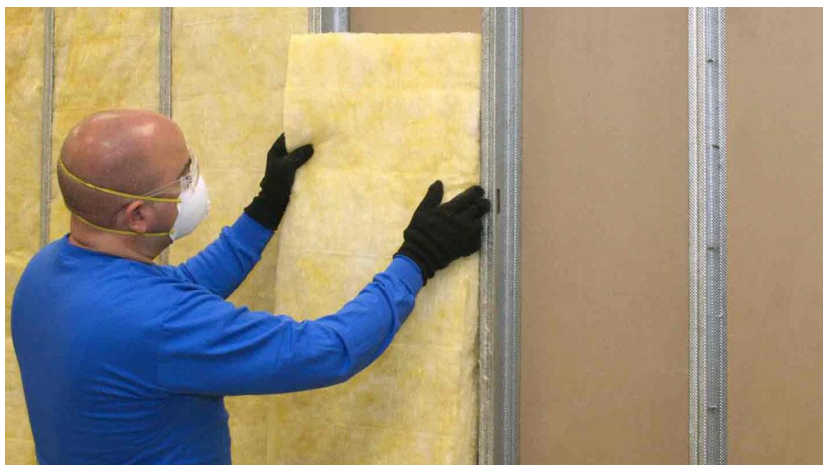
Figura 11 – Aplicação na lã de vidro em alvenaria Drywall
