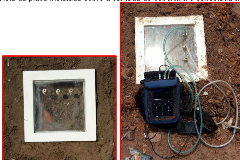
Figura 4. Vista da placa instalada sobre a camada de cobertura e conectada ao GEM5000
