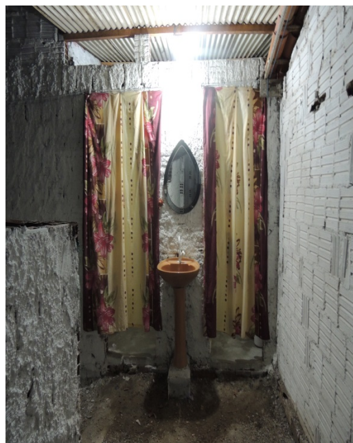
Banheiros depois da última reforma
