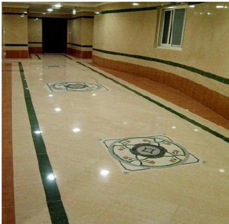
Figura 01- Piso revestido com porcelanato.
