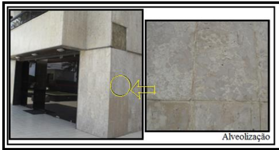
Figura BV 7.4 - Alveolização em revestimento de fachadas de edifício com placas de Calcário Bege Bahia, litoral do Recife-PE, Brasil.
