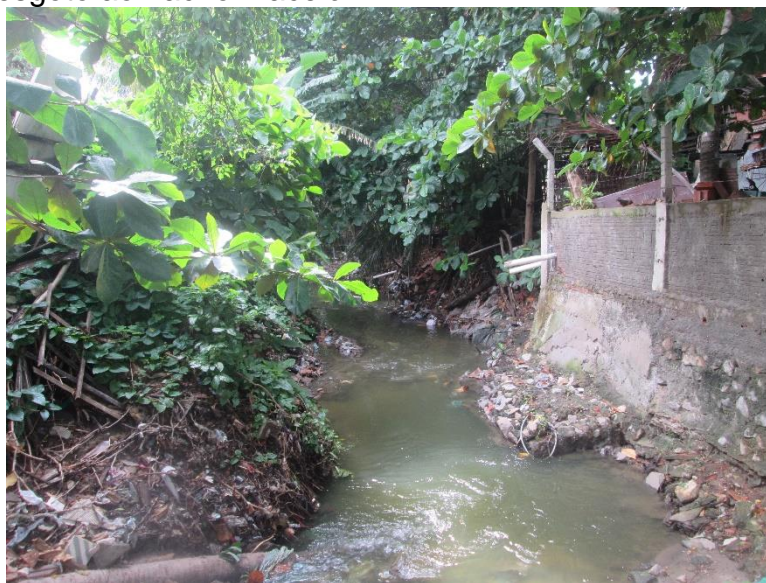
Figura 14 – Assoreamento e ligações diretas de esgoto ao riacho Maceió.
