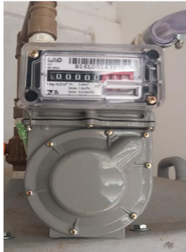
Figura 25 - Medidor de biogás
