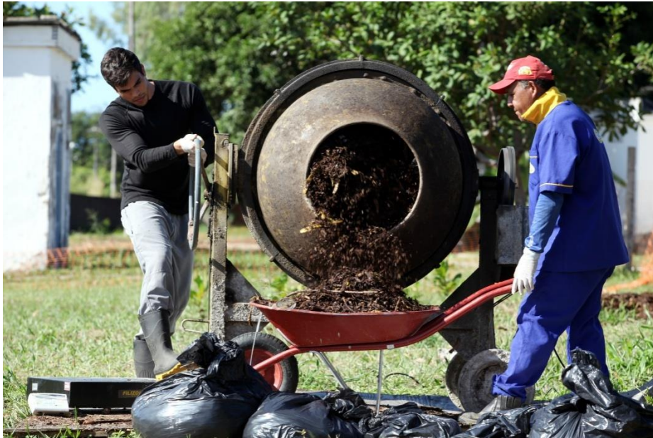
Figura 13 – Vista do processo de homogeneização prévia dos resíduos em betoneira
