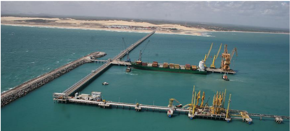
Figura 07: Estrutura off-shore finalizada e em operação. Píeres 1 e 2.
