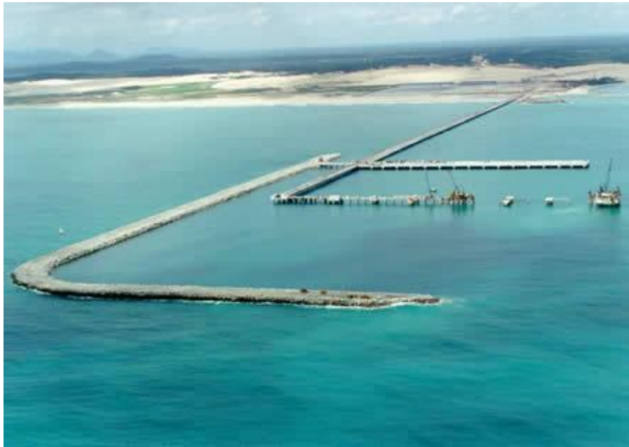
Figura 06: Estrutura off-shore em construção. Quebra mar e píer 1 finalizados e píer 2 em fase adiantada.
