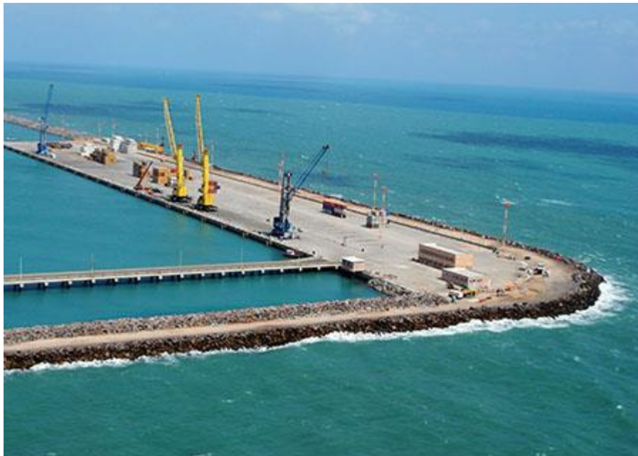
Figura 08: Estrutura do TMUT com os novos berços 5 e 6 prontos.
