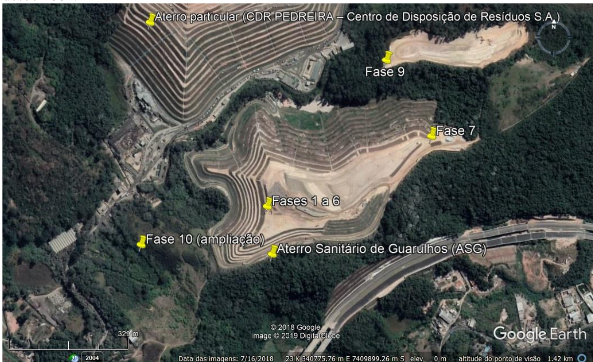
Figura 17 – Imagem de satélite do Aterro Sanitário de Guarulhos (ASG) e fases de operação desde 2001.
