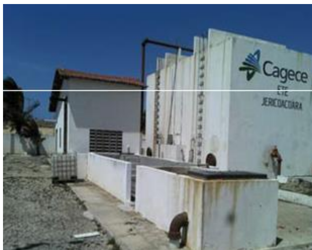
Figura 15 - Estação de Tratamento de Esgoto (ETE)
