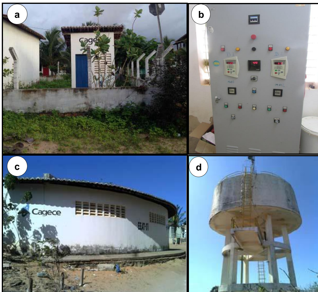
Figura 12 – Sistema de abastecimento de água na Vila de Jericoacoara: (a) poço de captação da CAGECE, (b) central de controle, (c) Estação Elevatória de Água, (d) Reservatório elevado.
