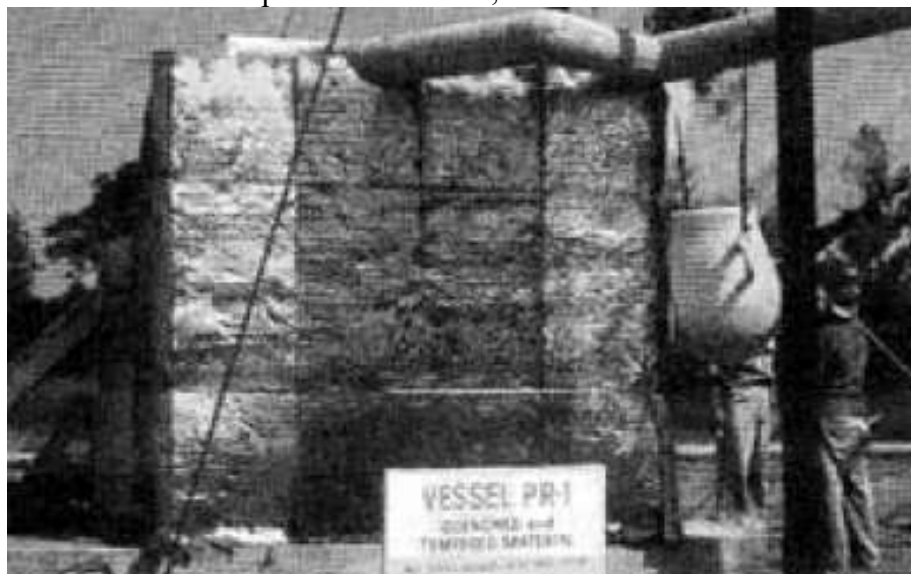
Figura 13 - Protótipo de tanque de navio em aço 9Ni na condição temperado e revenido, como soldado.
