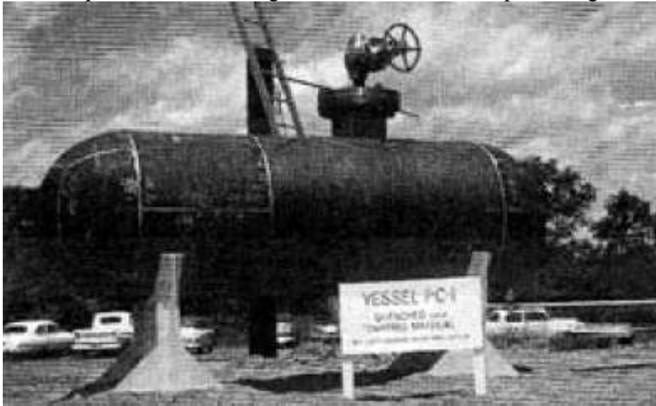
Figura 12 - Teste de pressão em vaso fabricado com aço 9Ni na condição temperado e revenido seguido de alívio de tensões pós soldagem
